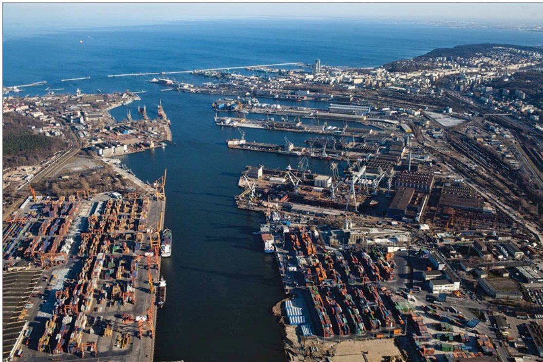
Ryc. 6.6. Port w Gdyni od strony Estakady Kwiatkowskiego.
