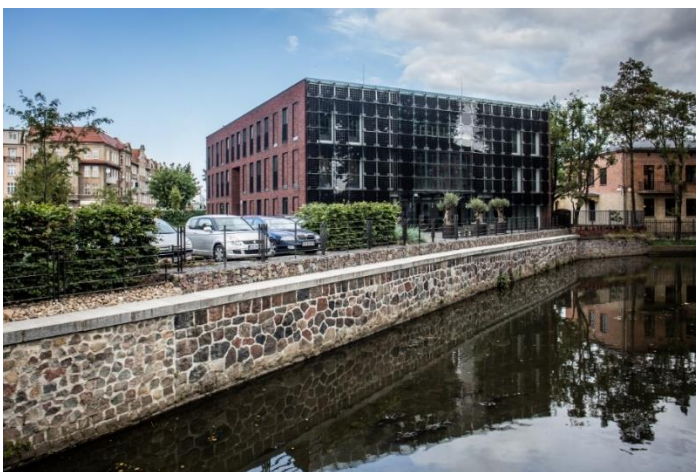
Il. 54. Budynek Wojewódzkiego Funduszu Ochrony Środowiska i Gospodarki Wodnej, Gdańsk, proj. A-Plan Bis, 2015-2016, źródło: wfos.gdansk.pl
