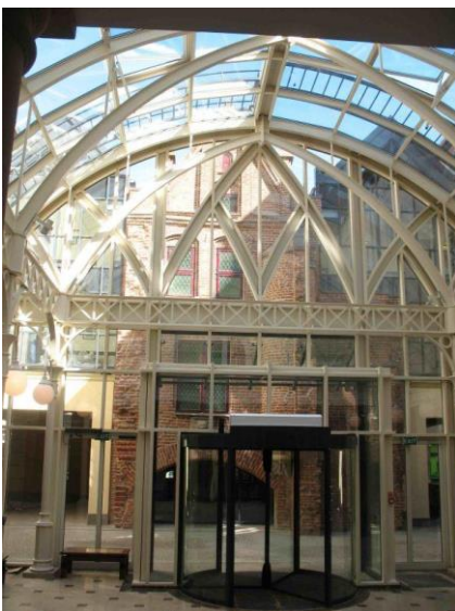
Il. 60. Atrium hotelu Rezydent (obecnie Radisson Blu), Gdańsk, proj. Piotr Rutkowski, Zbigniew Młodzianowski, 2004-2009, źródło: architektura.muratorplus.pl
