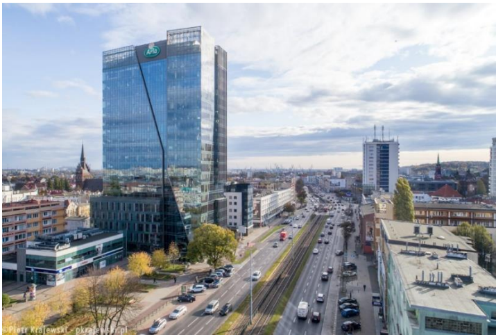
Il. 47. Centrum Biurowe Neptun w kontekście urbanistycznym Górnego Wrzeszcza, Gdańsk, proj. AHR Architects, 2012-2014, źródło: skyscrapercity.com
