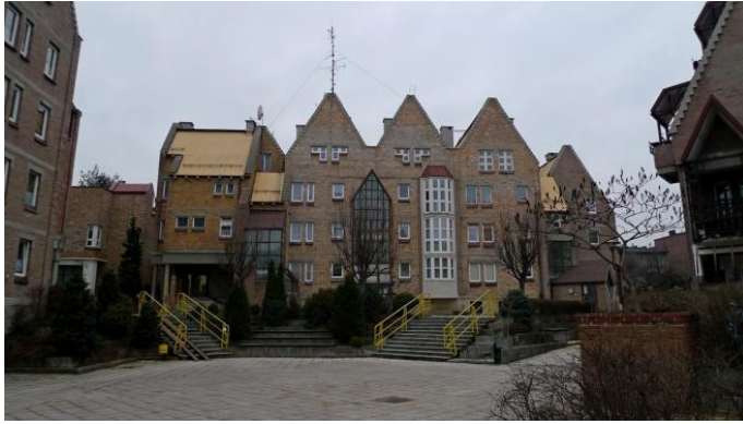
II. 7. Osiedla nad Jamną, Mikołów, proj. Stanisław Niemczyk, 1983-1986, źródło: sztuka-architektury.pl
