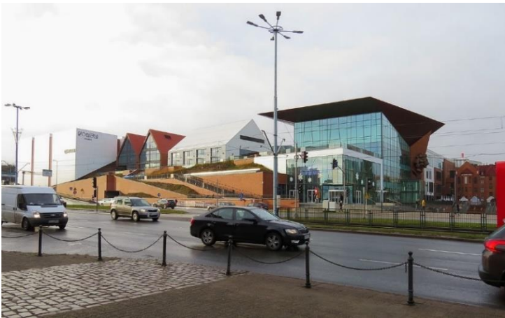
Il. 35. Forum Gdańsk od strony wschodniej czyli od strony Drogi Królewskiej, źródło: wikipedia.org
