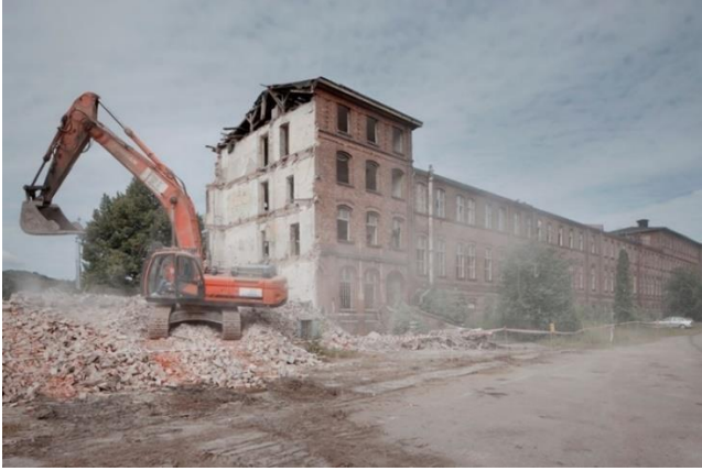
Il. 82. Zdjęcie z cyklu „Paskudne pocztówki” przedstawia budynek pochodzący z początku XX w. w trakcie burzenia na gdańskich terenach postyczniowych, fot. Michał Szlaga
