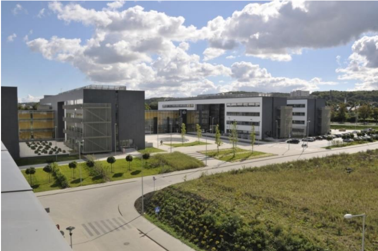
Il. 70. Budynek Wydziału Chemii, proj. Warsztat Architektury Pracownia Autorska WAPA, 2010-2012, fot. Michał Narloch
