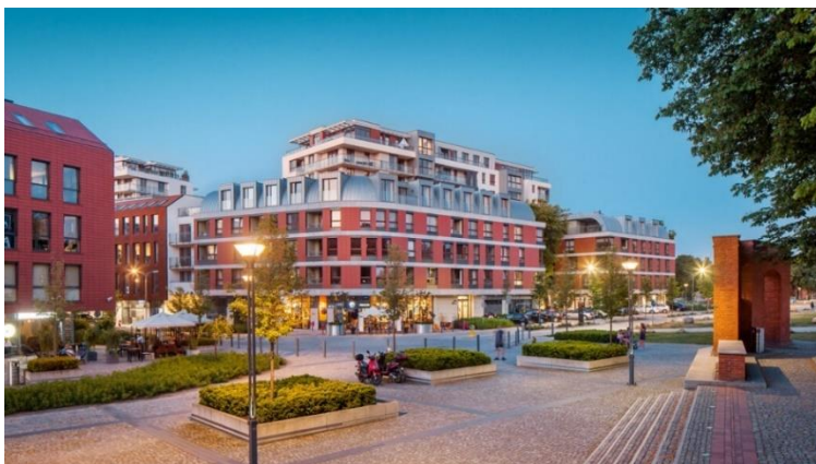
Il. 111. Część zabudowy Garnizonu pomiędzy ulicami Norwida i Hemara, Gdańsk, proj. Marcin Woyciechowski, 2017, źródło: hossa.gda.pl
